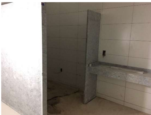
11 – Colocação de cubas e divisórias de banheiros.
