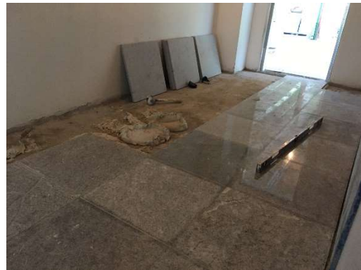
08 – Assentamento de piso de granito polido hall de elevadores, 1º e 2º pavimentos.
