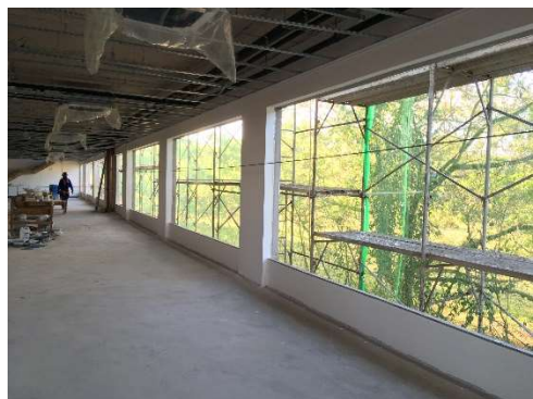
16 – Emassamento de paredes, colocação de peitoril de granito das esquadrias.
