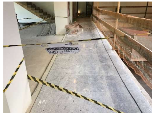
10 – Piso de granito polido, corredores do 1º e 2º pavimentos.
