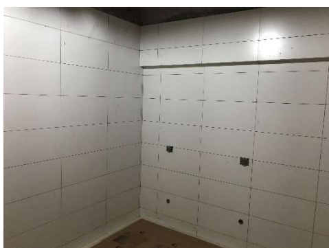
22 – Revestimento cerâmico de paredes e pisos.
