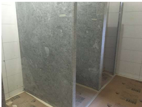
20 – Divisórias de granito e revestimento cerâmico de parede e piso.
