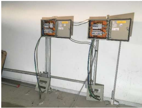
07 – Passagem de cabos de energia e ligação nos quadros.
