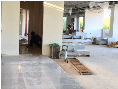
09 – Assentamento de piso de granito polido.
