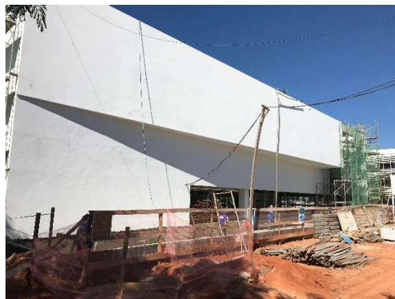
25 – Emassamento e pintura de área externa.
