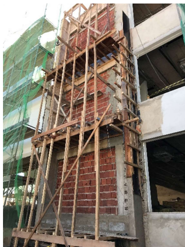
24 – Estrutura do shaft lateral.
