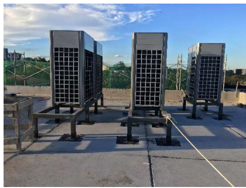
15 – Alocação das condensadoras nos suportes da cobertura.
