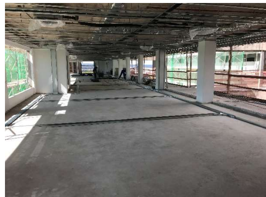
12 – Execução de calhas elétricas de piso no 1º e 2º pavimentos.
